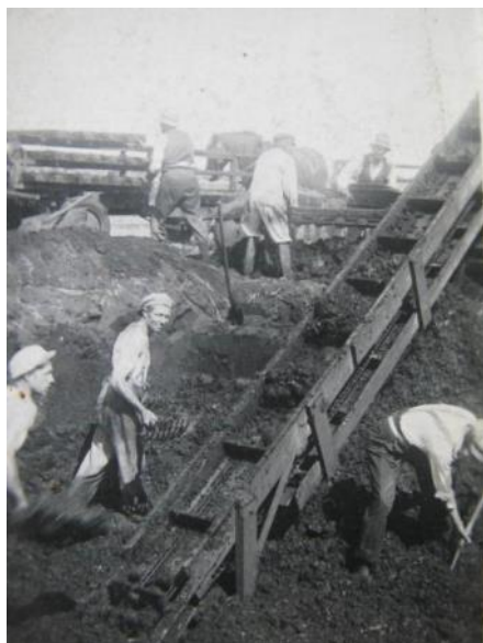
Der skovles tørvejord i elevator på Lyngen
