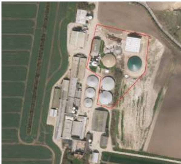
Biogasanlæggets bygninger (Rød markering) ligger sammen med svinebruget Lynggården.
